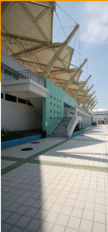
运动场入口楼梯间局部
